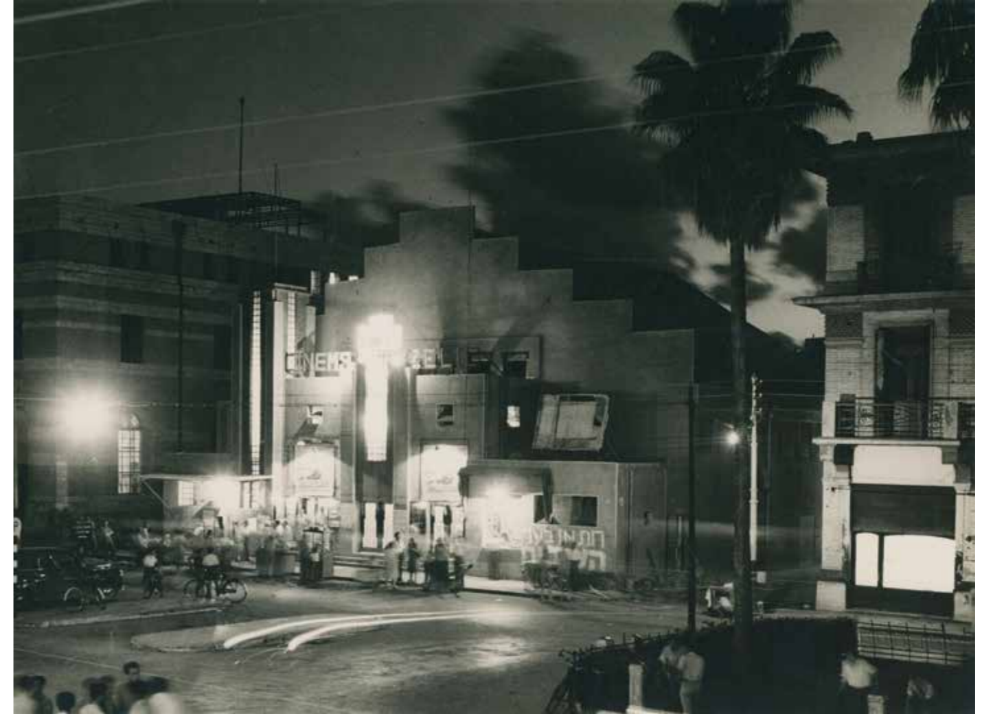
בוריס כרמי, קולנוע צליל, 1953, הדפס כסף, 15.8x21.5. הבניין בשדרות ירושלים 10 ביפו תוכנן על ידי האדריכל ג' ראשיד בשנת 1947 (באדיבות אוסף מיתר ע"ש משפ' פריצקר, הספרייה הלאומית)
