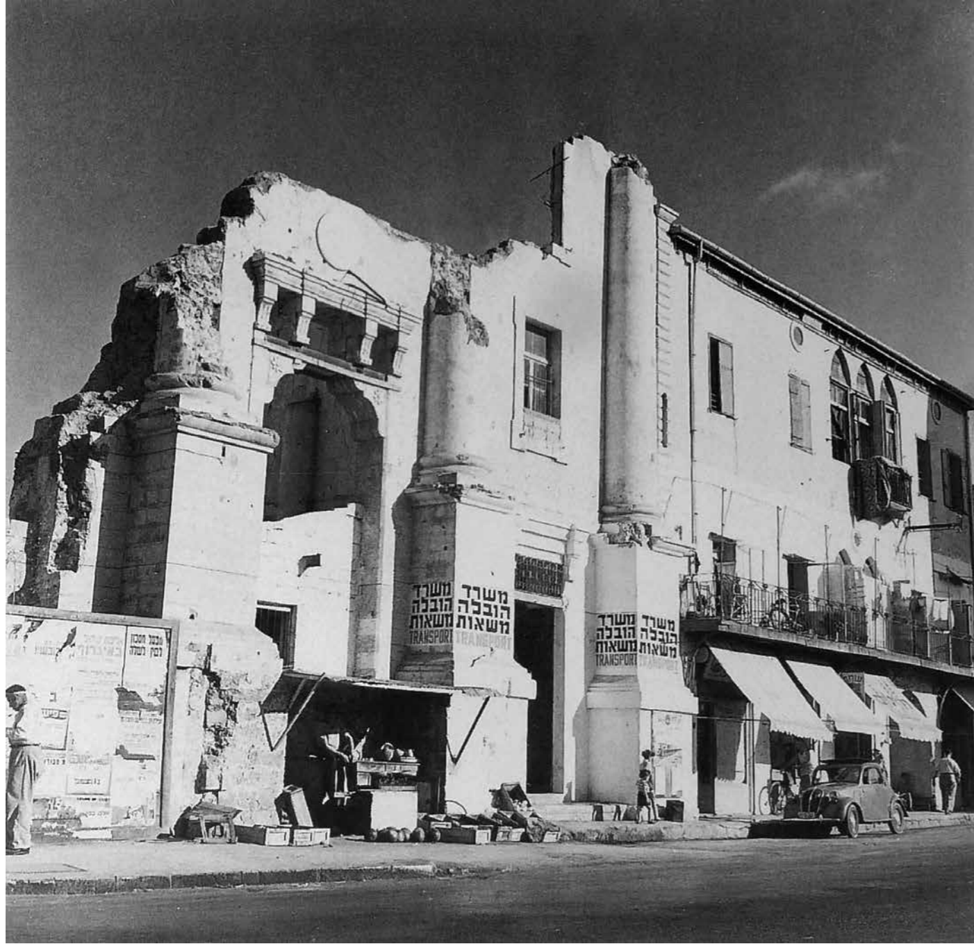
שלמה בן-דוד, בניין הרוס, יפו, ראשית שנות החמישים, רפרודוקציה מקטלוג (שלמה בן-דוד, ארנון בן-דוד, TAMA cat. 14/96) (תצלום: רן ארדה, מוזיאון תל אביב לאמנות)
