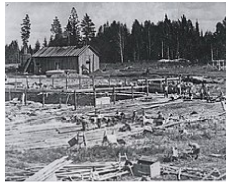
Начало строительства обогатительной фабрики СУМЗа , 1935 год
