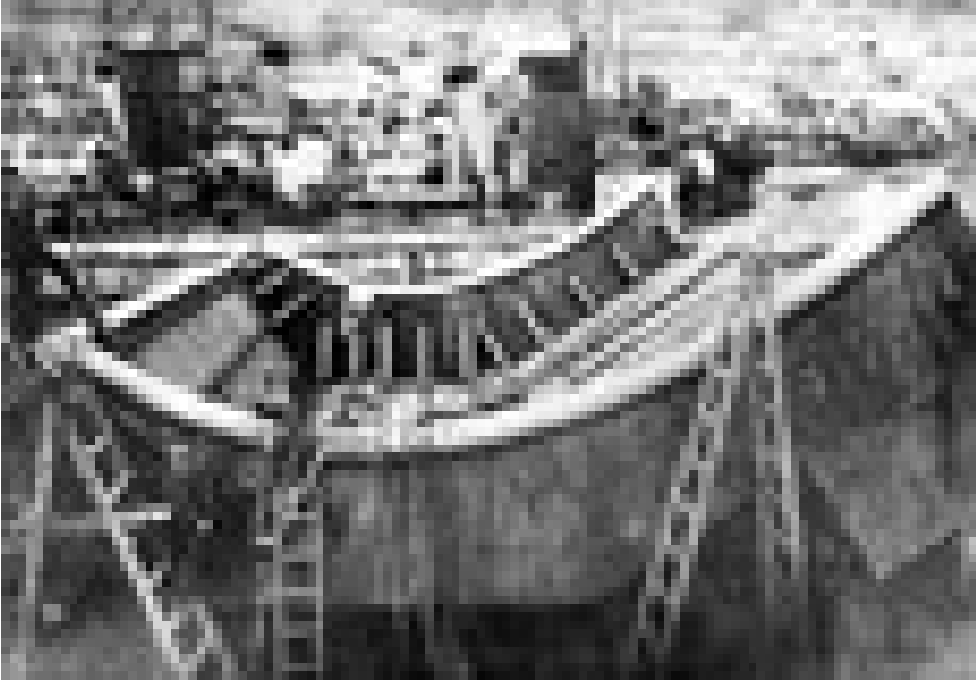
Yavuz'un 26 Aralık 1914'te aldığı mayın yaralarını tamir için Alman ve Türk mühendisler tarafından İstinye'de üretilmiş olan çelikten usturmaça. İstanbul'da Yavuz'u alacak büyüklükte bir havuz bulunmadığından ötürü hasarlı bölgeleri usturmaçalarla tecrit ettikten sonra suyu boşaltıp tamirata gerçekleştirmek gerekiyordu. Hemen arkada ise Muavenet sınıfı bir muhrip görülüyor.
