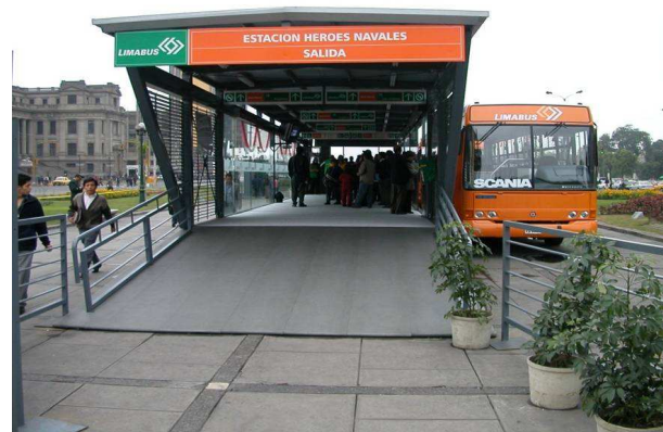
Estación modelo de estación BRT de Lima, Perú. Fuente: Fundación Ciudad Humana.
