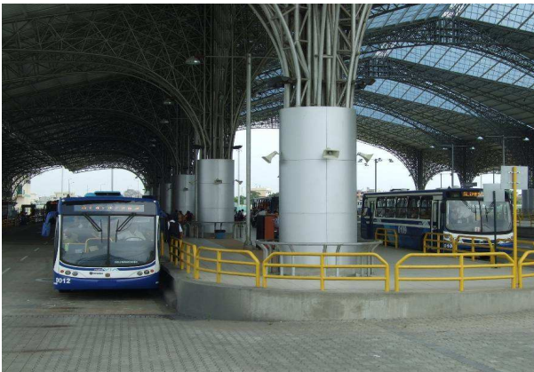
Sistema BRT de Guayaquil, Ecuador (Metrovía).
